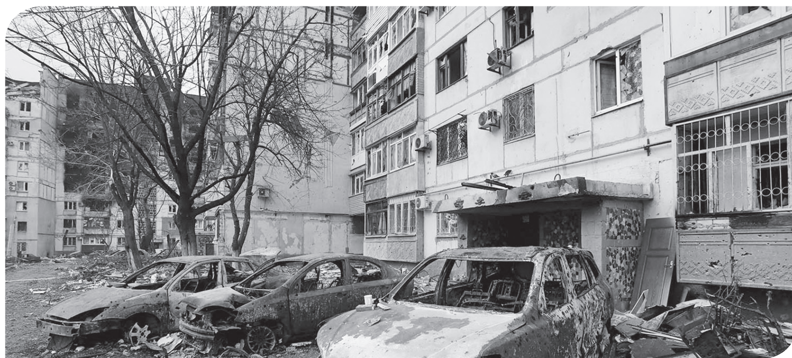
GEDUNG APARTEMEN RUSAK SELAMA KONFLIK UKRAINA - RUSIA
